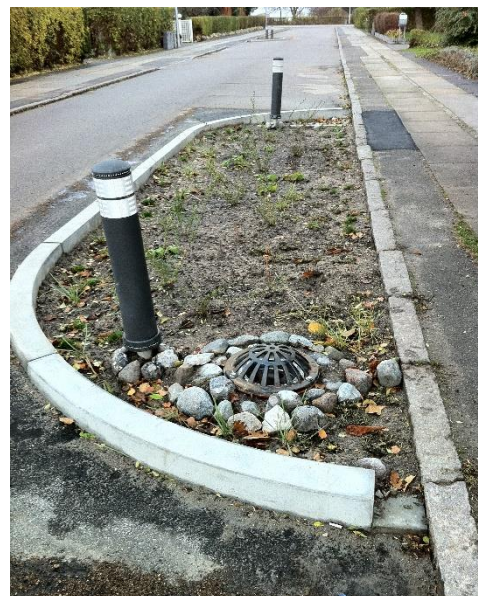
Figur 8. Billeder fra udførelse af et vejbed
