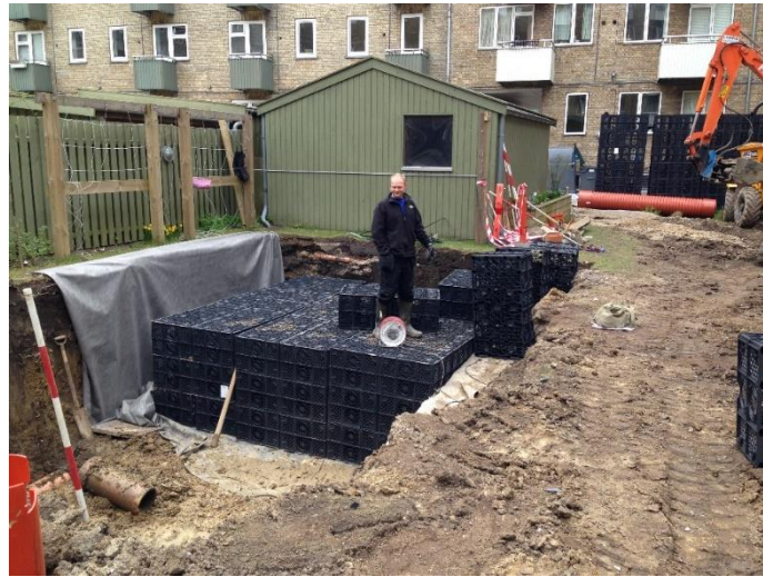
Figur 12. Mindre bassin udført af plastkassetter
