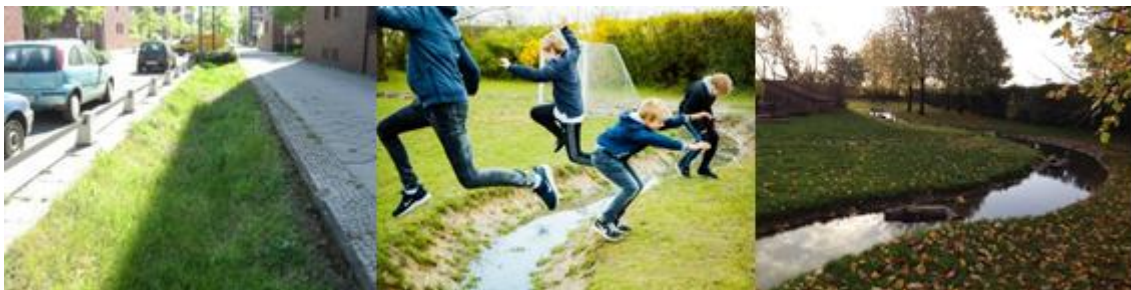
Figur 5. Afhængigt af design kan grøfter primært være et transportelement (stort fald, lille tværsnitsareal), eller både et transport- og et nedsivningselement (lille fald, så opholdstid bliver lang og med et vist magasin)
