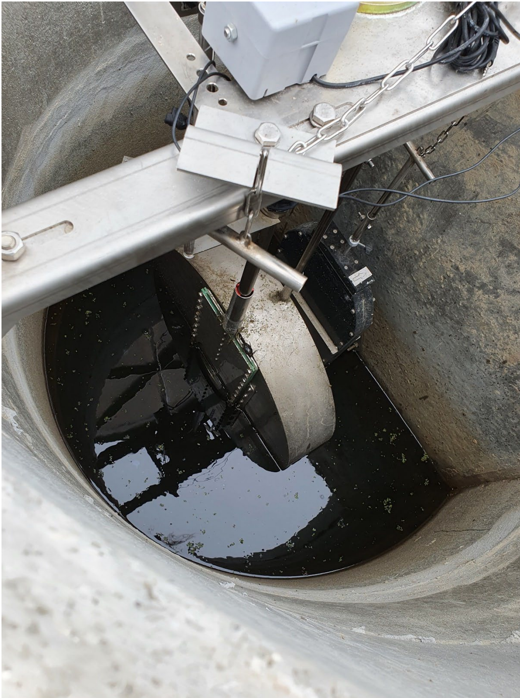
Figur 5-5 Den færdige prototype af ReLeVand-bremsen [kilde: https://vandportalen.dk/ ]
