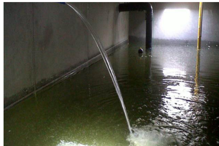
Foto 2 Opfyldning af lagertank med drikkevand med luftgub
