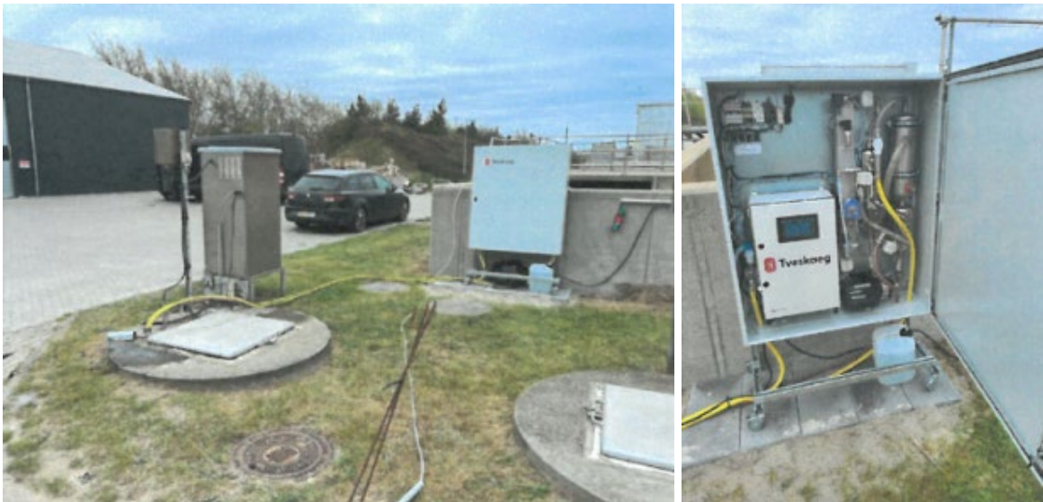
Figur 5. Venstre: Opstilling af målesystemet Tveskæg koncentrator på KALUNDBORG CENTRAL RENSEANLÆG. Højre: Tveskæg koncentrator.
