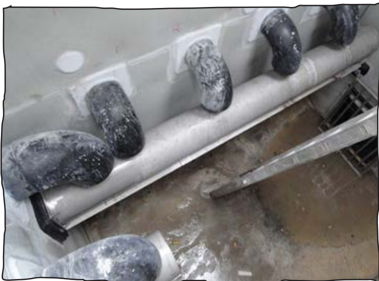
Figur 20: Overfladebeskyttelse af pumpeump med PE-plader
