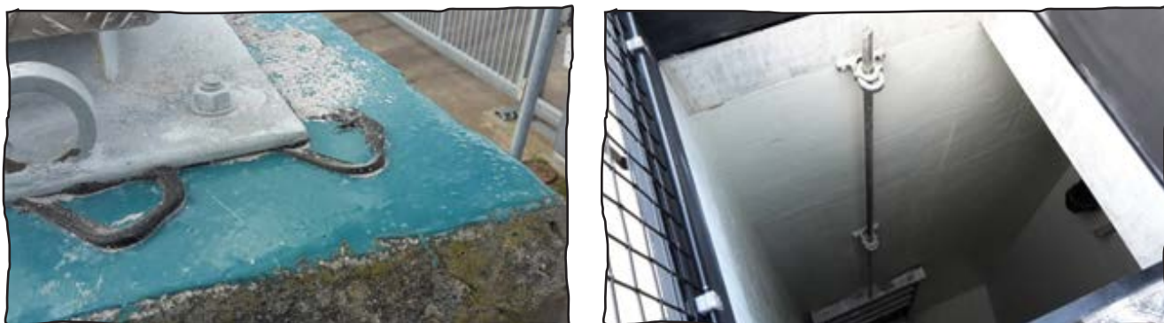
Figur 21: Coatning af betonoverflader
