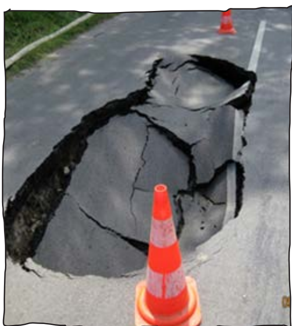
Figur 15: Sammenstyrtet vej grundet gennemtæring af gravitationsledning
