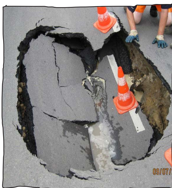
Figur 15: Sammenstyrtet vej grundet gennemtæring af gravitationsledning
